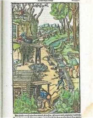
Darstellung der Seifenarbeit bei Agricola (1556). Angestautes Wasser fließt über eine Holzrinne in einen Waschkasten mit Lochblech.
